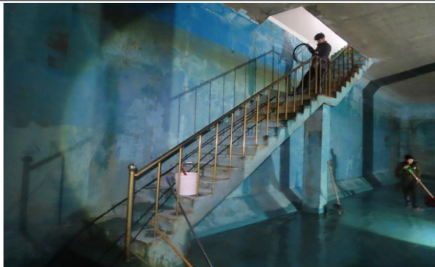
배수지 2지 안전난간 상태양호
