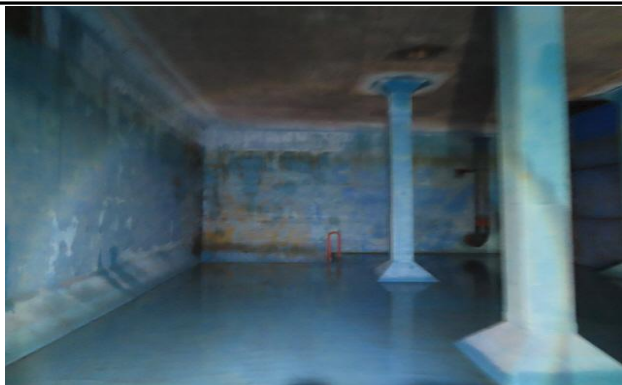
배수지 2지 내부 전경
