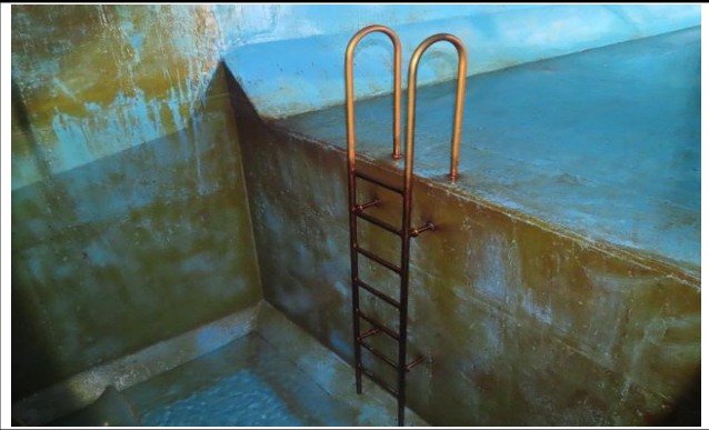
배수지 1지 집수정 사다리 상태양호
