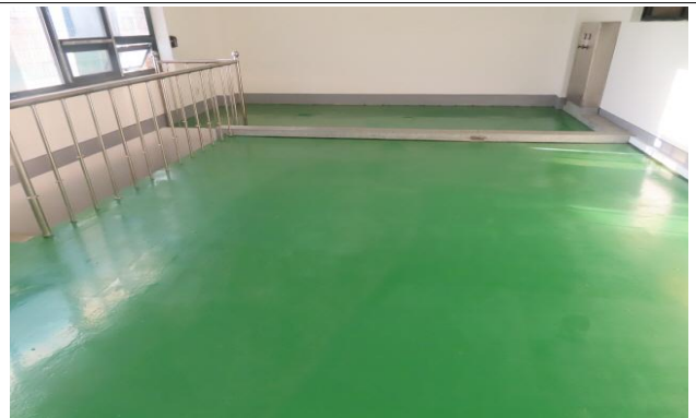
밸브계단실 내부 상태양호
