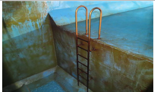
배수지 1지 집수정 사다리 상태양호
