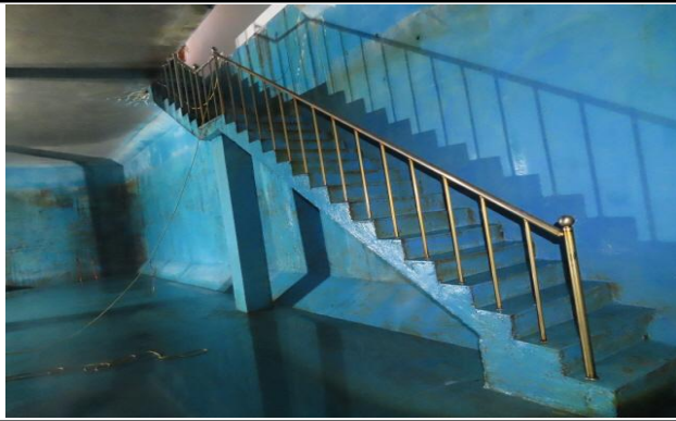
배수지 1지 안전난간 상태양호
