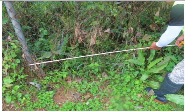
부재 손상 제원측정
