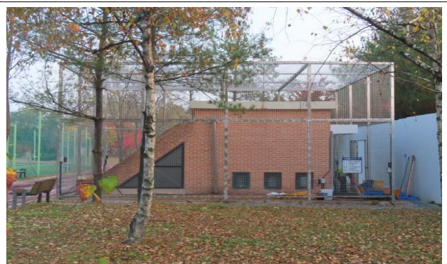
배수지 주변 상태양호
