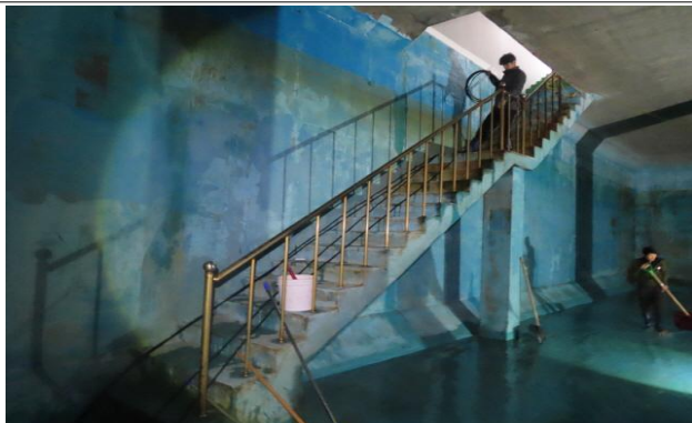
배수지 2지 안전난간 상태양호
